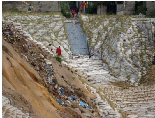
Control del daño usando sacos rellenos de tierra anclados con barreras de Vetiver
