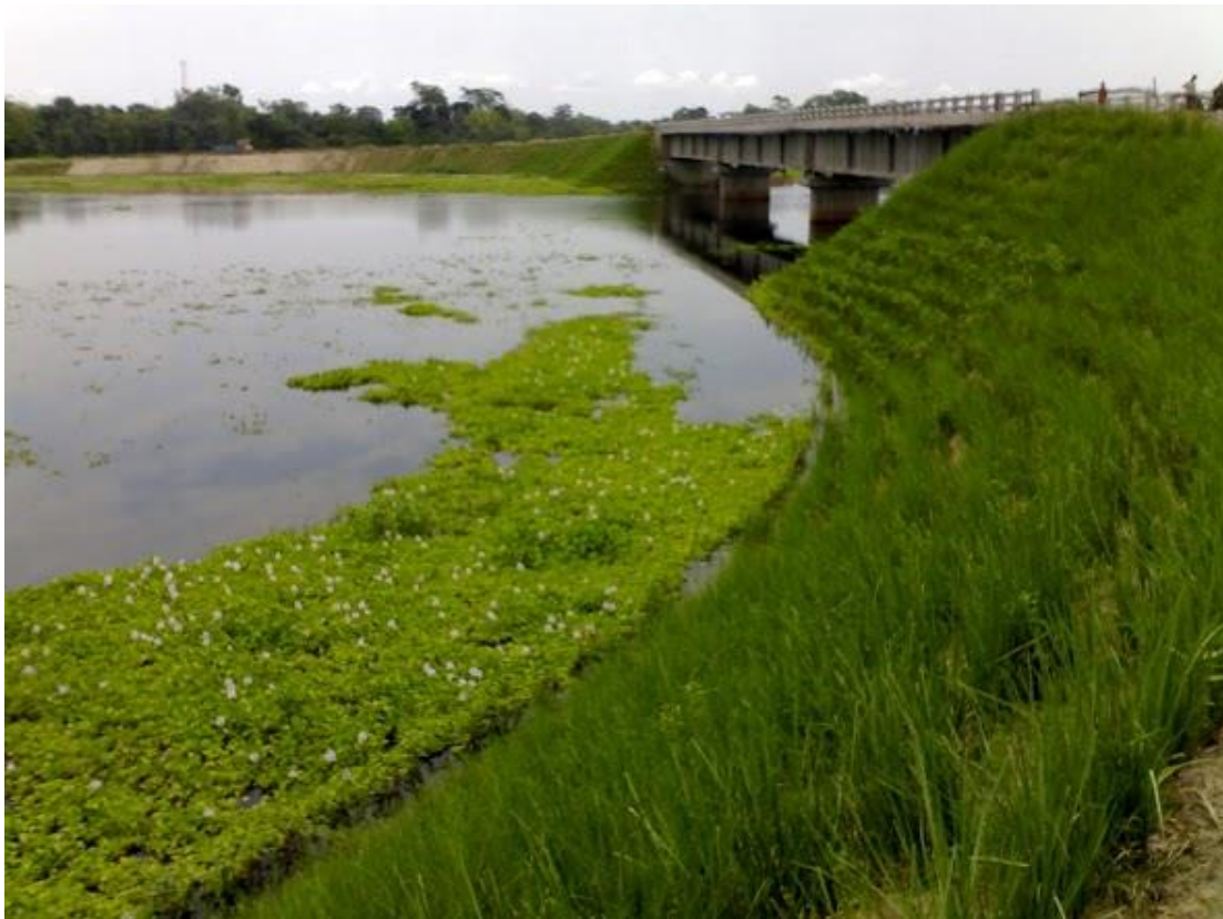
Vetiver protegiendo estribo de puente
