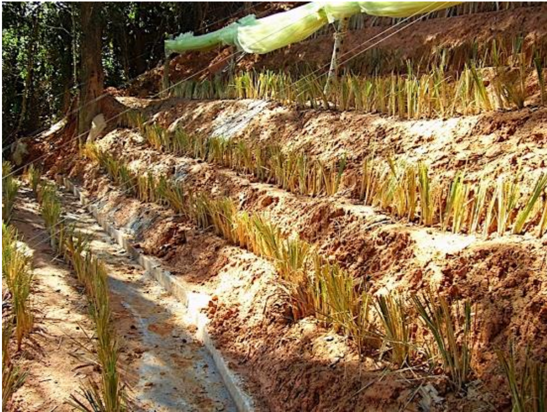
Barreras de Vetiver protegiendo de la sedimentación canal de desagüe
